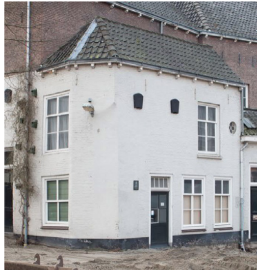
Het portiersgebouw (foto: G. Oldenmenger, 2019)
