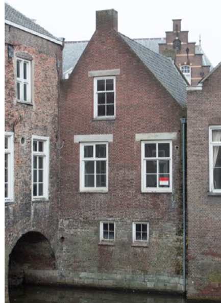
Diezegevel Medicamentengebouw (foto: G. Oldenmenger, 2019)
